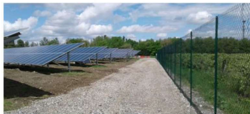
Noé (31) – 5MWc Réhabilitation d'un site dégradé (désamiantage du sol)
